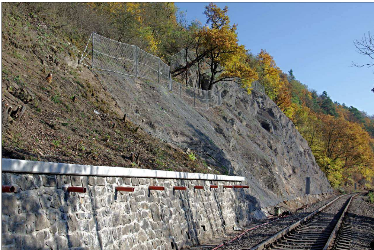
Ukázka ocelových sítí, kotevních prvků a ochranného plotu v horní části.
