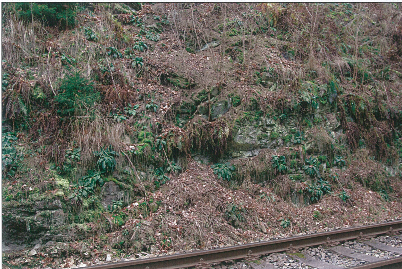
Foto – 3 Pohled v km 47,300 na rozvolněný líc svahu.
