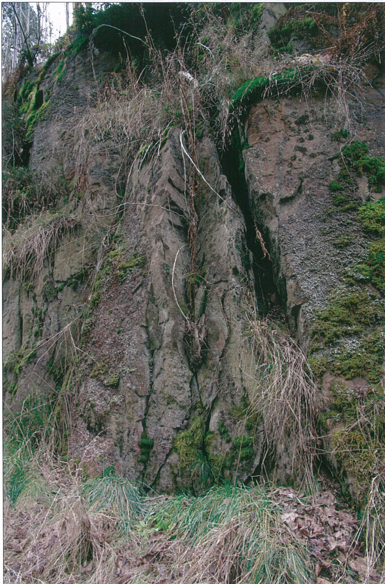
Foto – 16 Detailní pohled vpravo v km 43,550 na otevřené pukliny v líci svahu.
