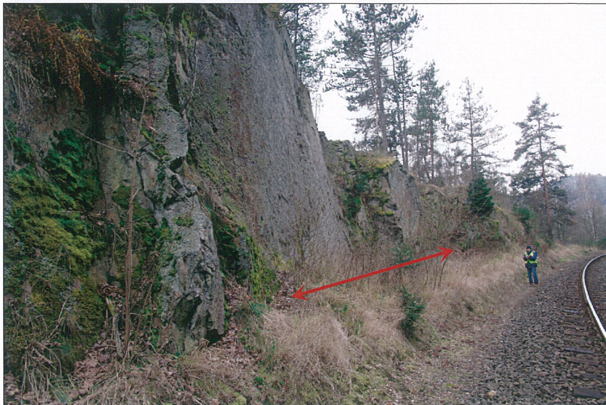
Foto – 14 Pohled na pravý svah z km 43,550 směrem na Mariánské Lázně. Šipka ukazuje na úsek svahu, který nevyžaduje zajištění.
