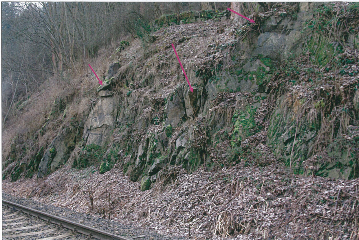
Foto – 3 Pohled v km 37,440 na zcela rozvolněné bloky horniny v líci jak ukazují šipky.
