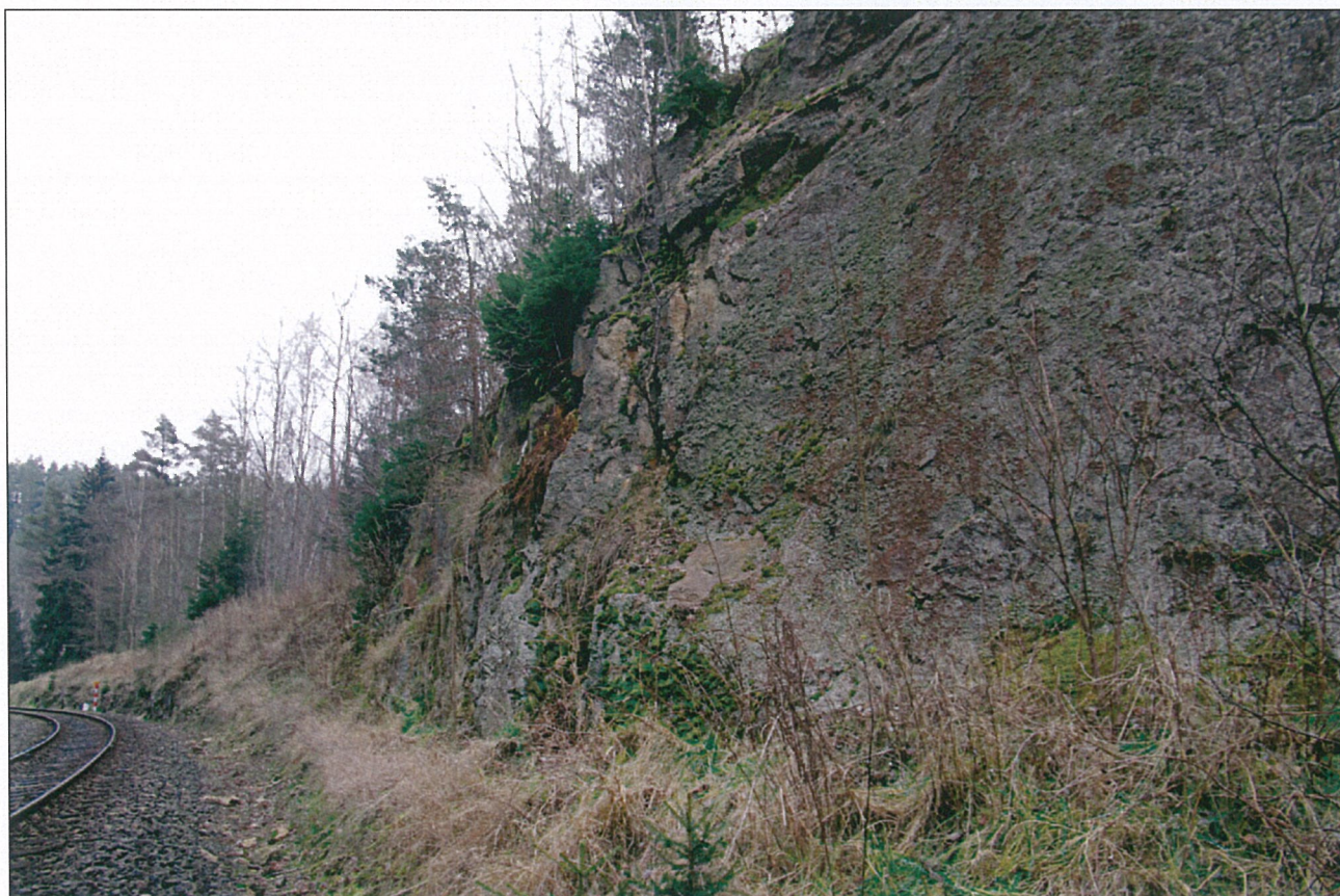
Foto – 13 Pohled směrem na Karlovy Vary z km 43,550 vpravo . Připovrchová partie svahu je značně rozvolněná.
