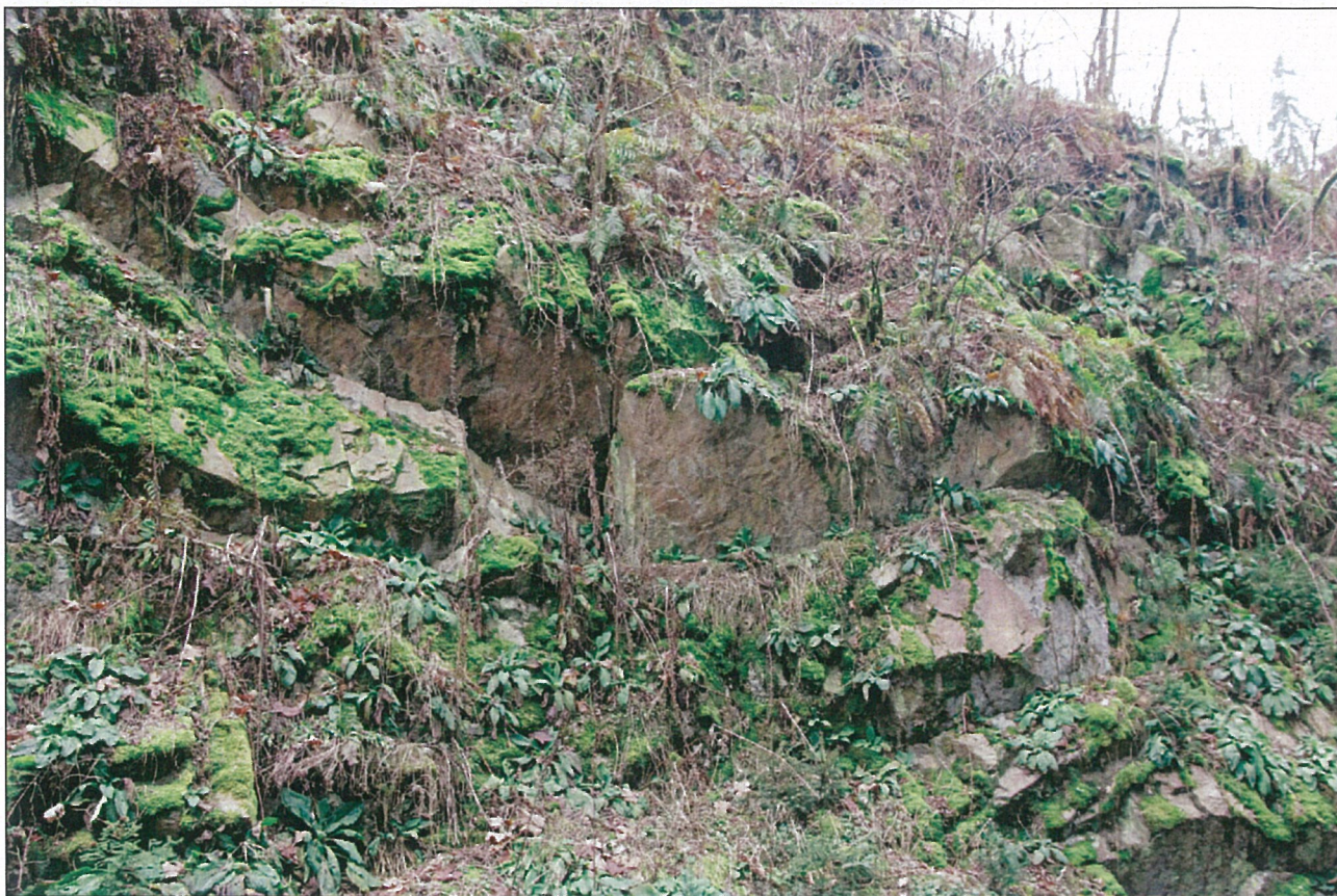
Foto – 3 Pohled na totálně rozvolněný líc svahu v km 47,680. Pukliny jsou otevřené.
