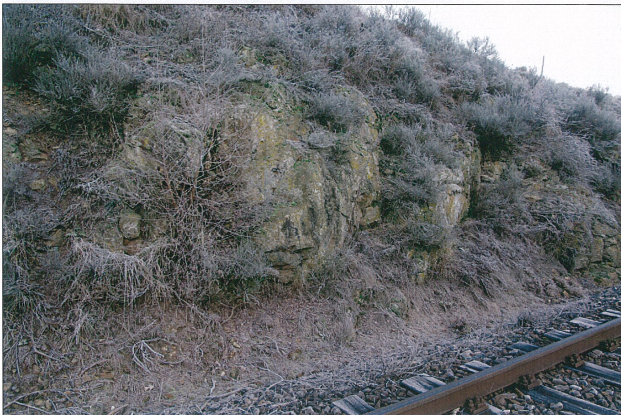
Foto – 3 Pohled na rozvolněné bloky v odřezu v km 25,860.
