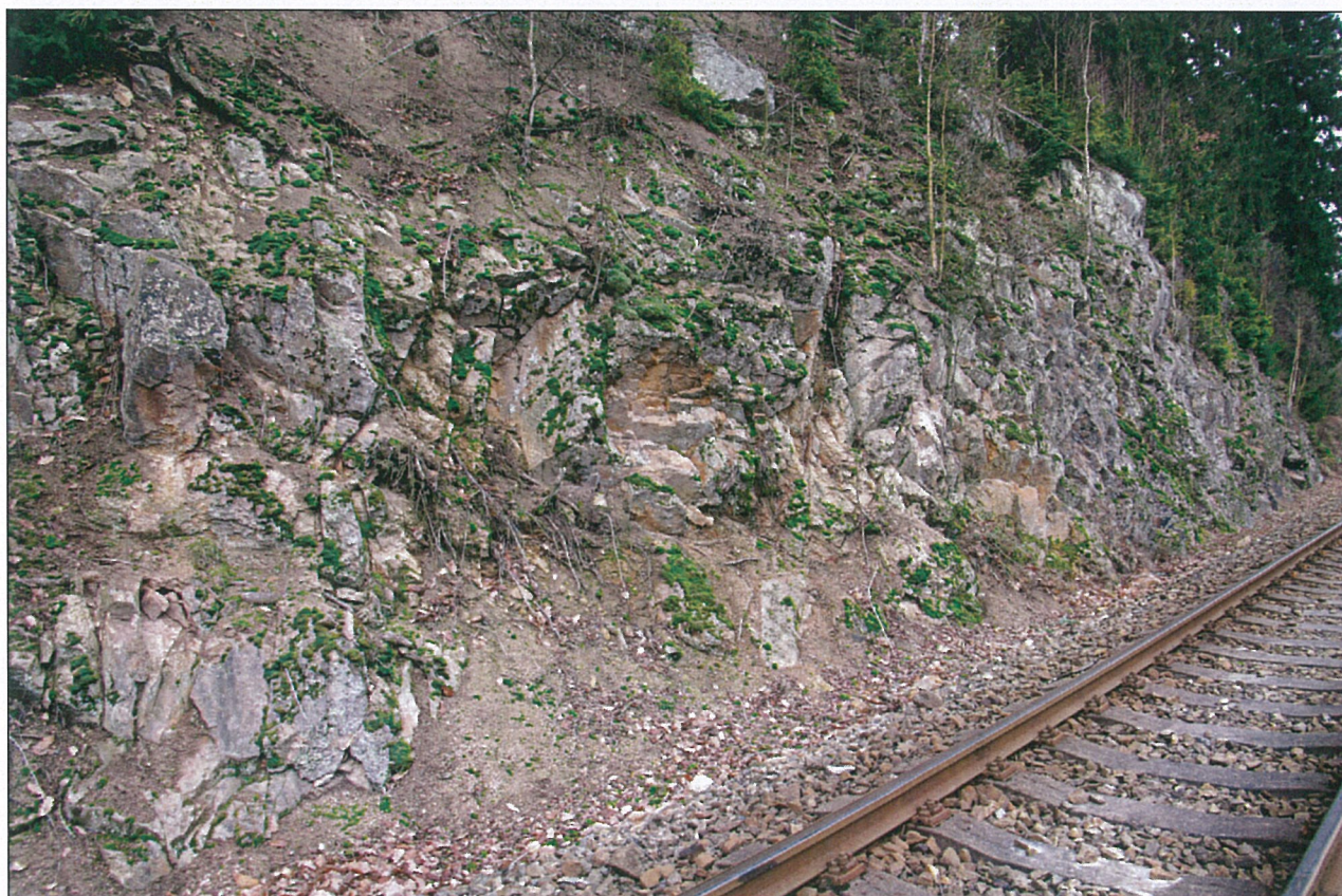
Foto – 2 Pohled v km 44,600 na zcela rozvolněný líc svahu.
