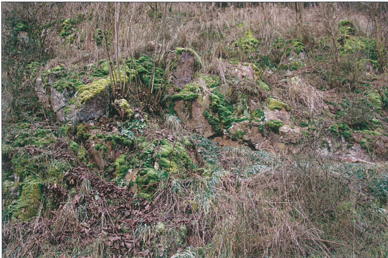
Foto – 5 Detail rozvolnění horniny v líci svahu v km 39,330.
