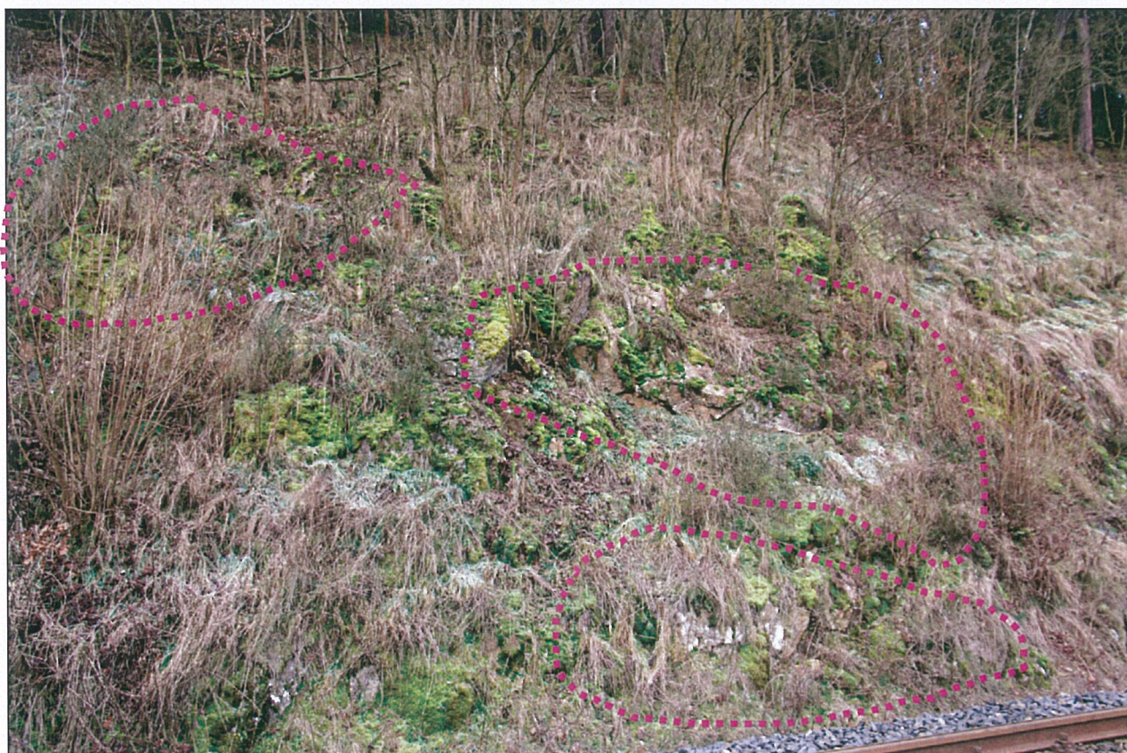
Foto – 4 Pohled na svah v km 39,330 s rozvolněnými bloky, jak ukazuje omezení oblastí karmínová čára.
