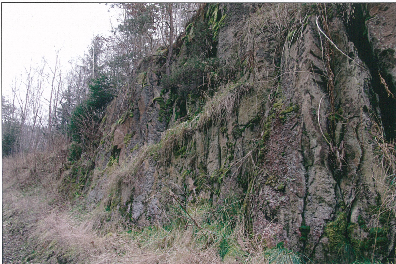
Foto – 15 Pohled na pravý svah směrem na Karlovy Vary se zcela rozvolněným lícem.
