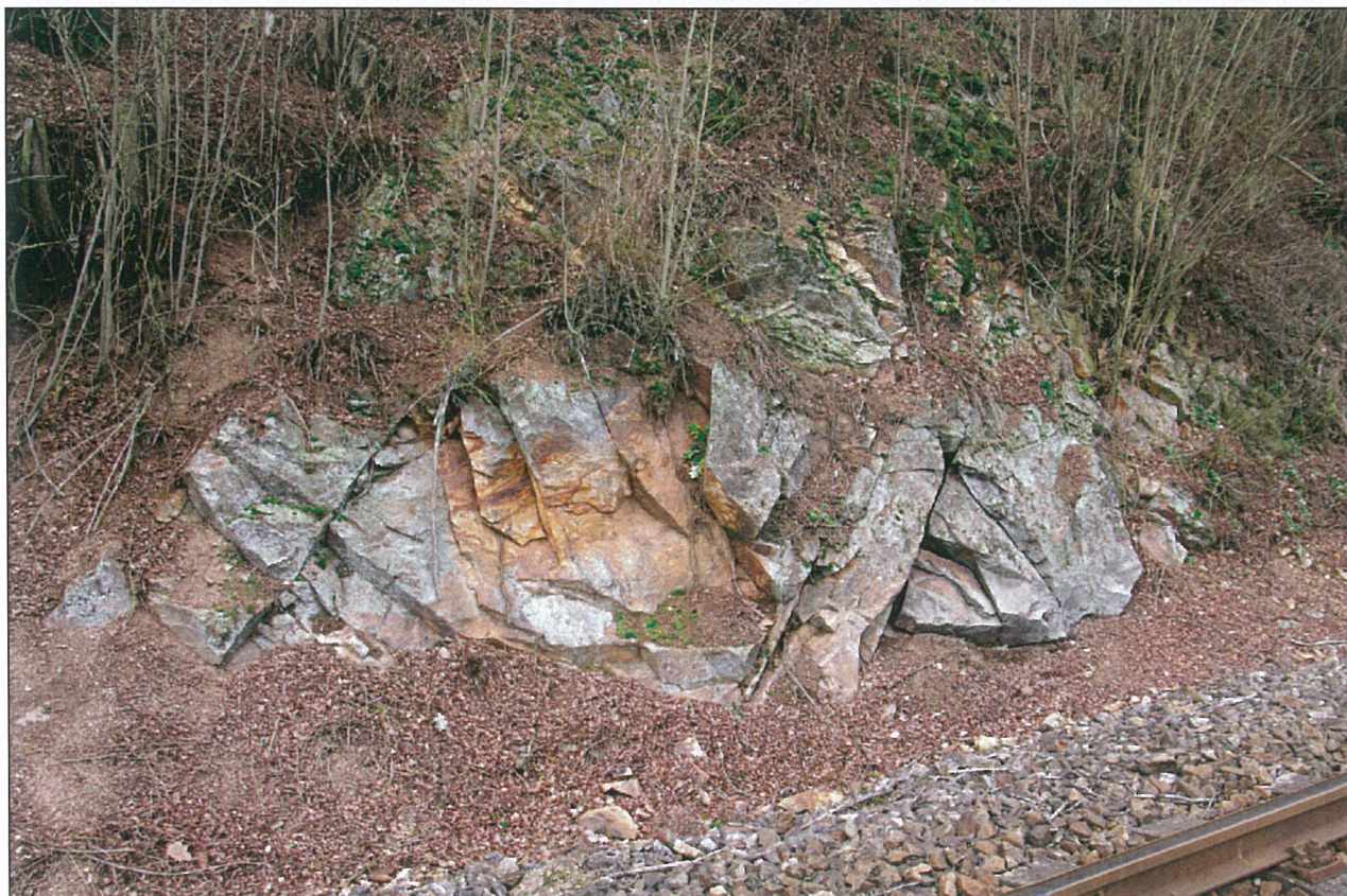
Foto – 4 Pohled na všesměrně rozpukanou horninu v líci svahu v km 44,670.
