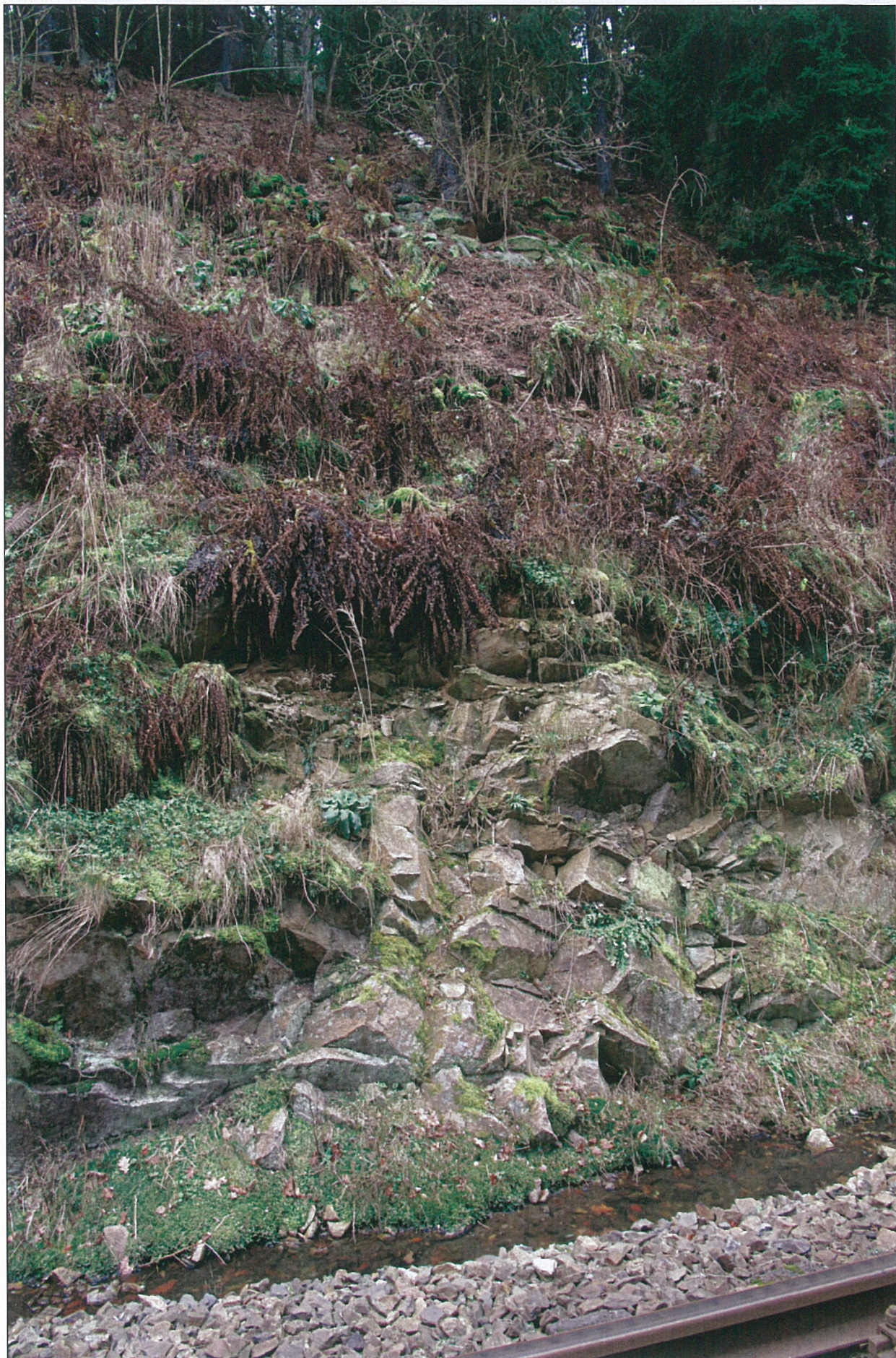
Foto – 5 Detail rozvolnění masivu.
