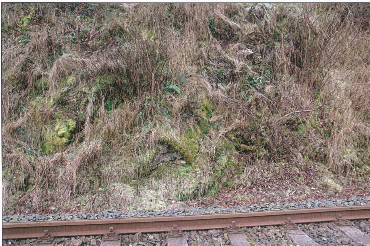
Foto – 2 Pohled na rozvolněné bloky v travním porostu svahu v km 39,310.
