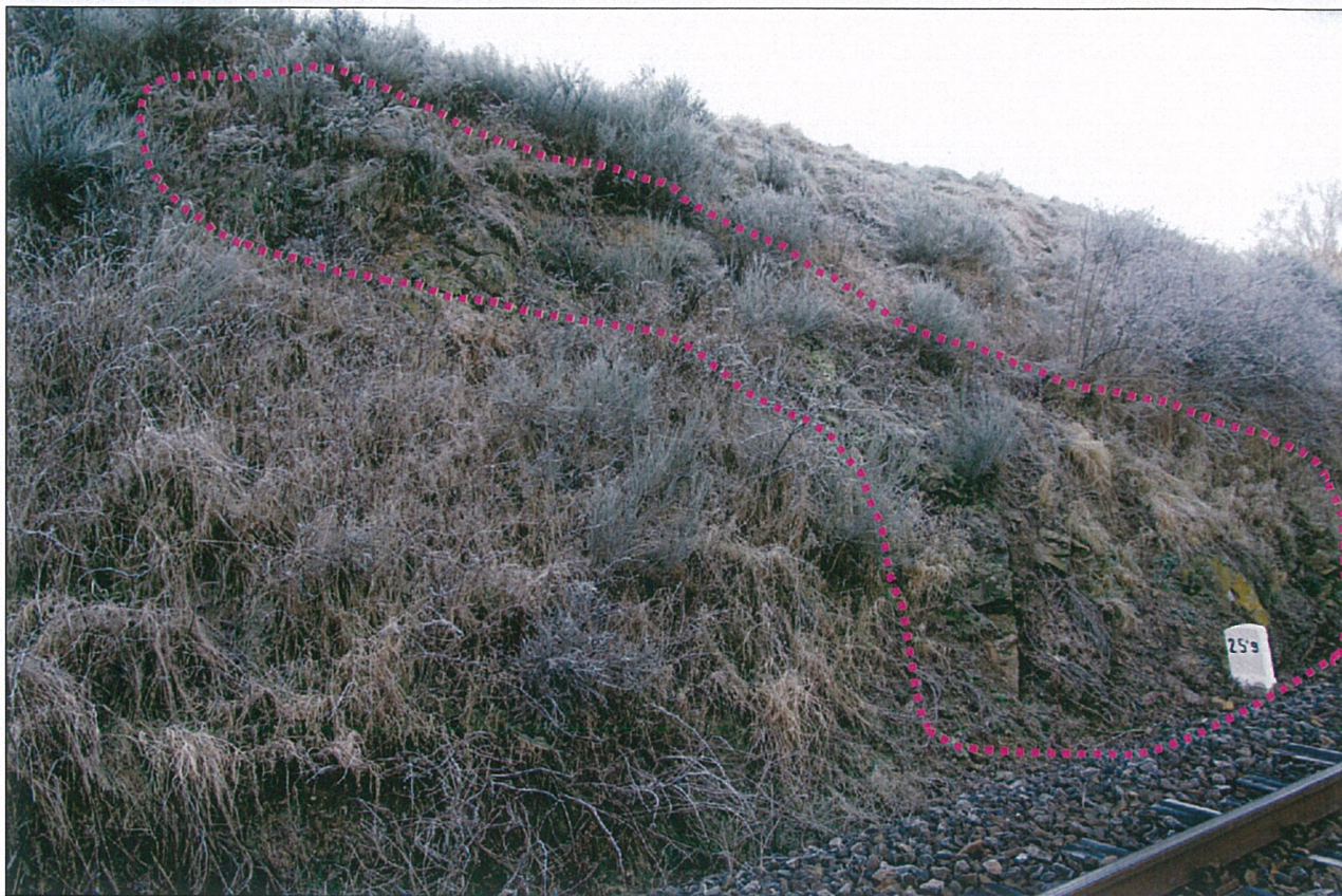
Foto – 5 Pohled na rozvolněné bloky v km 25,900 jak vymezuje karmínová čára.
