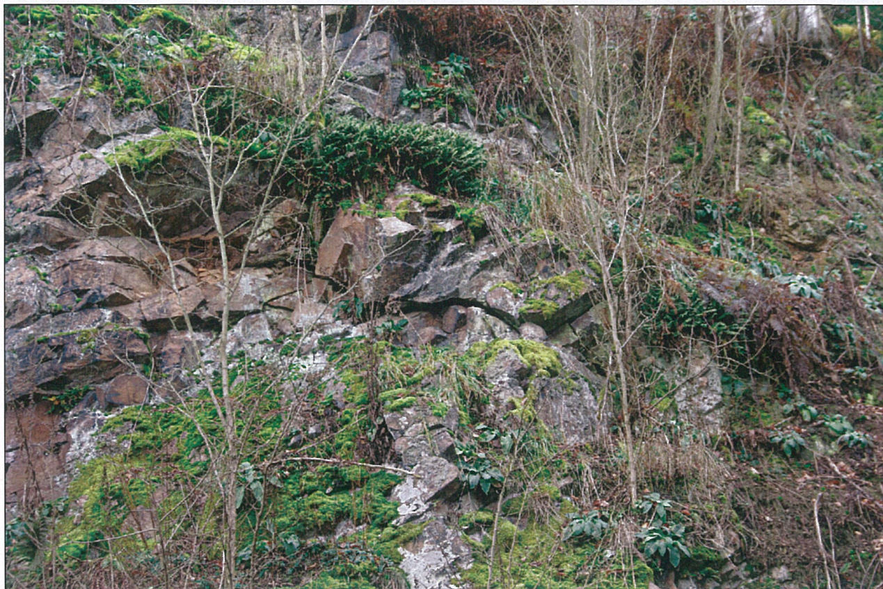
Foto – 3 Pohled na svah s otevřenými puklinami v líci v km 46,755 cca 3,5 m nad kolejí.
