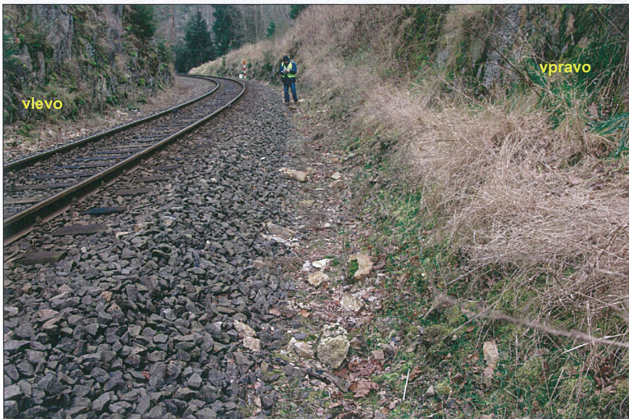
Foto – 8 Pohled na vypadlé fragmenty horniny z pravého svahu do příkopu. Pohled na Karlovy Vary.
