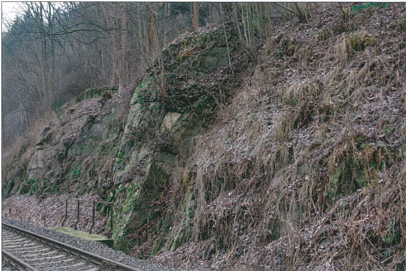
Foto – 5 Pohled k Mariánským Lázním v km 37,481 na značně rozvolněnou horninu v líci svahu odřezu.
