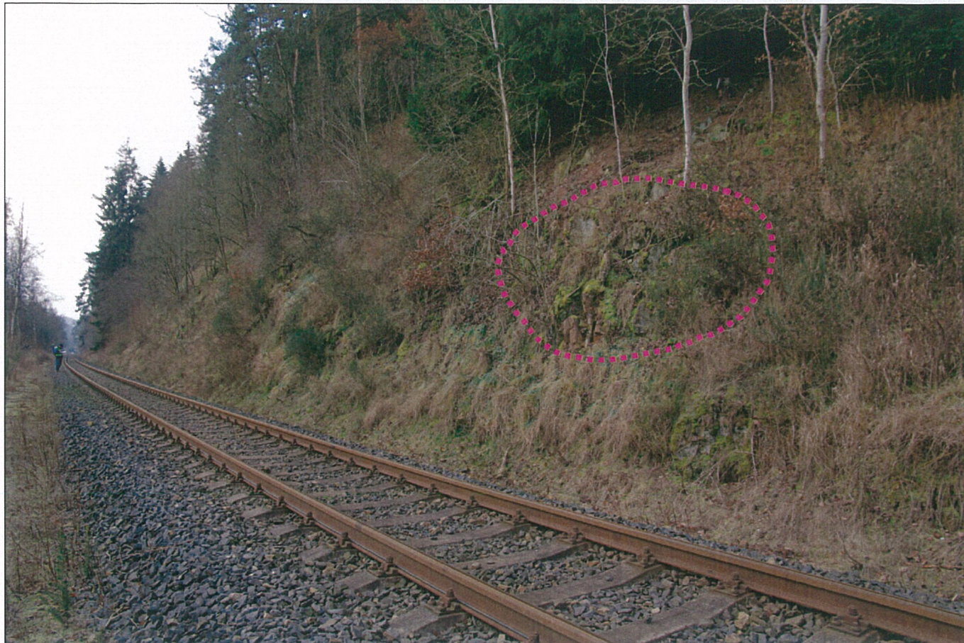
Foto – 8 Pohled k Mariánským Lázním z km 39,400. V popředí je vyznačená oblast se zcela rozvolněnou partií.
