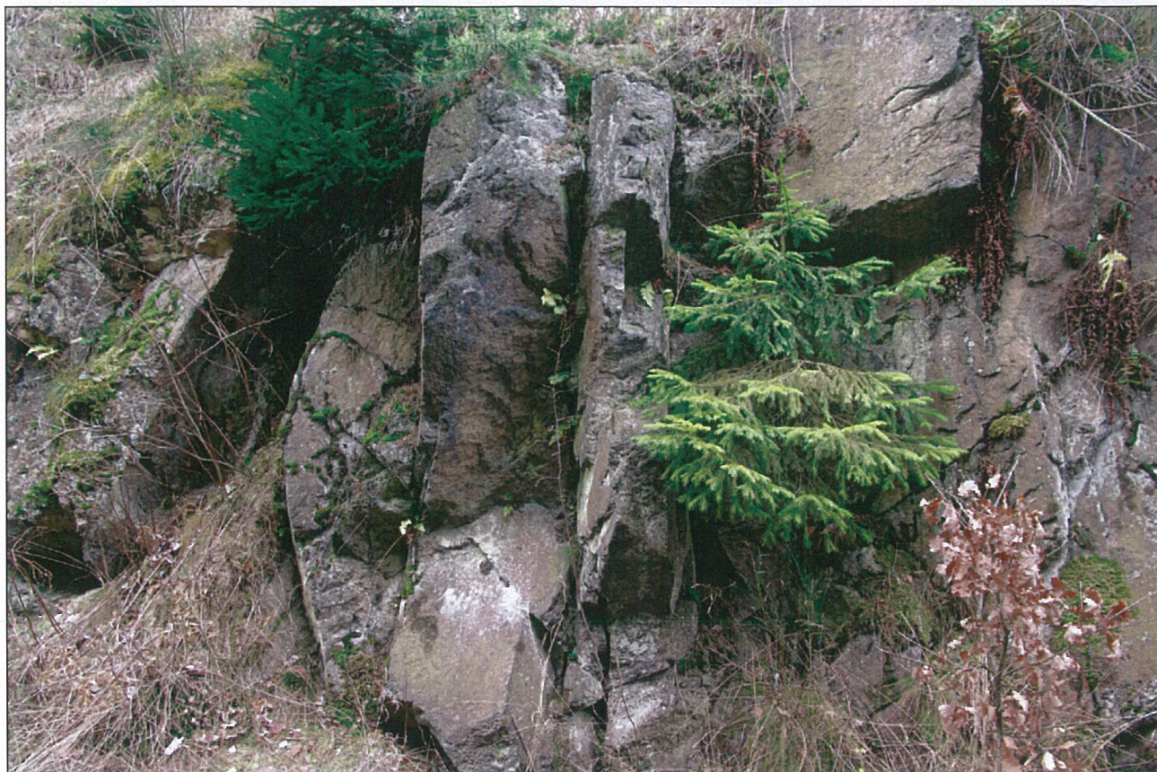
Foto – 10 Pohled na rozvolněný masiv vpravo v líci v km 43,500.
