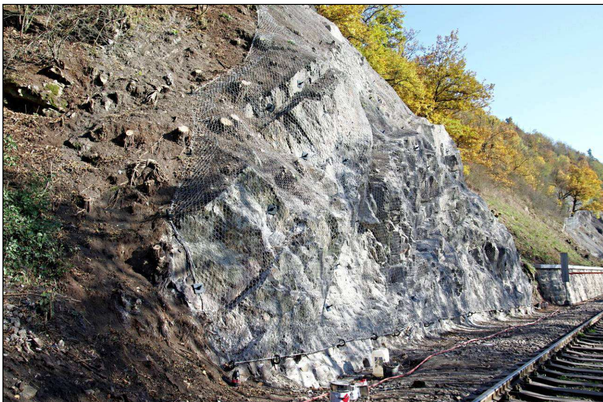
Ukázka ocelových sítí, kotevních prvků a napínacích lan po obvodě.
