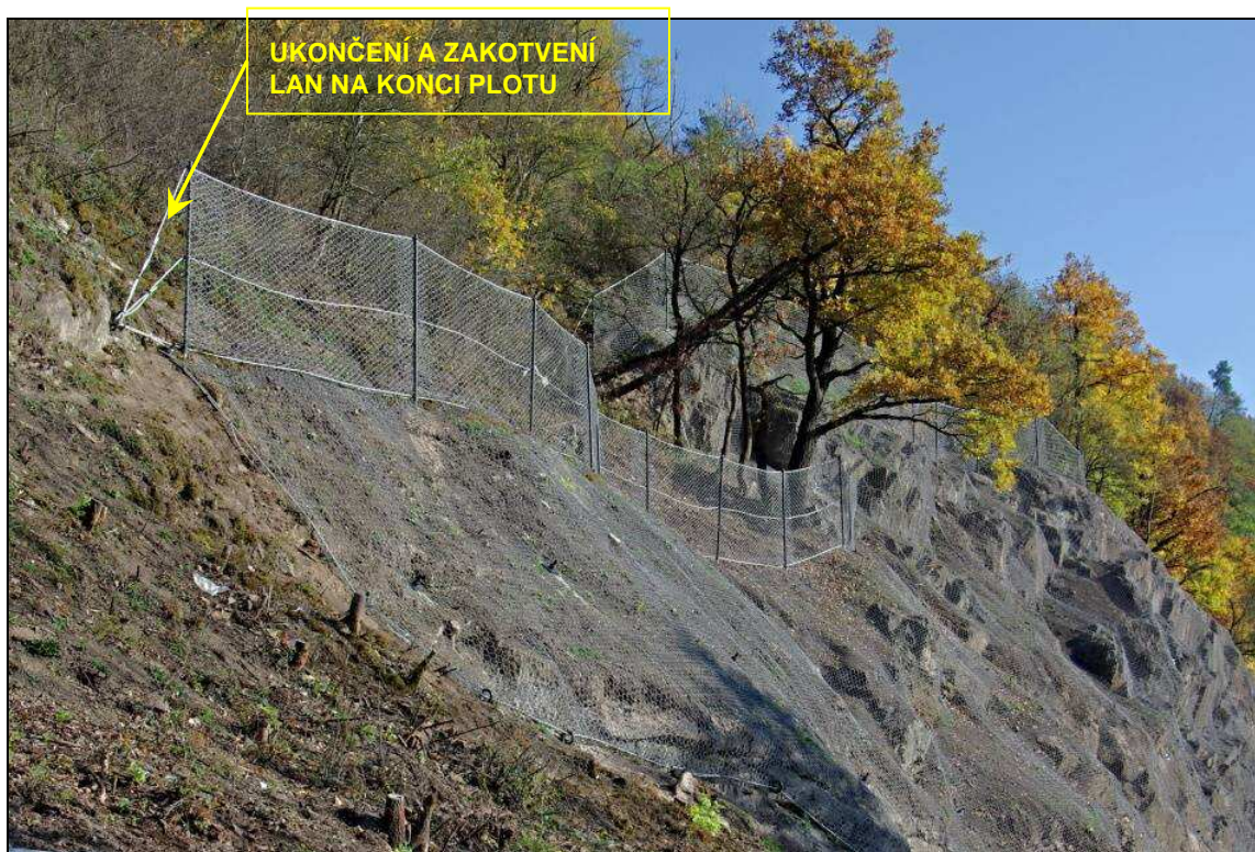
Detail záchytného plotu v horní partii zajišťovaného svahu.
